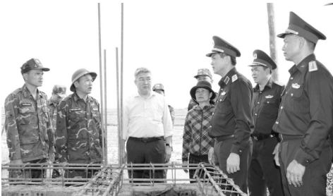
●Đoàn công tác kiểm tra tiến độ xây dựng một căn nhà. (Ảnh: Nhật Anh)
