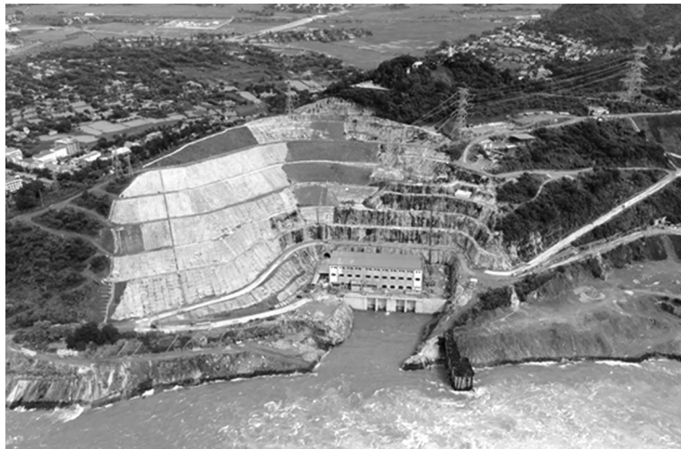
● NMTĐ Hòa Bình mở rộng cung cấp 480MW cho hệ thống điện quốc gia. (Ảnh: PV)
