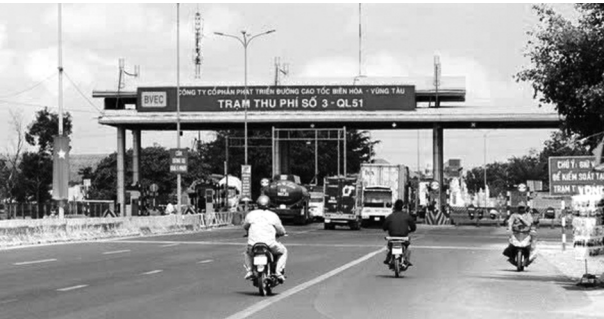
● Sở Xây dựng đánh giá công trình này đang vi phạm Luật Trật tự, an toàn giao thông đường bộ.
