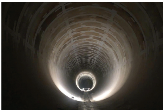
● Đường hầm dẫn nước có đường kính lớn nhất trong các công trình thủy điện hiện nay.
