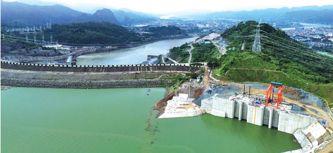
● Hình ảnh thi công Nhà máy thủy điện Hòa Bình mở rộng vào tháng 7/2025.
