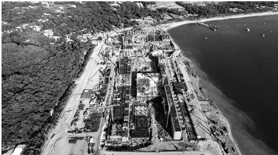
● Khu vực thi công Trung tâm Hội nghị và Triển lãm APEC.
