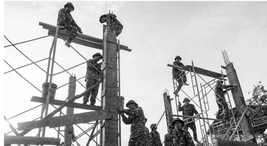
● Đến 31/12/2025, toàn quân đã xây dựng, sửa chữa, bàn giao được gần 400 nhà cho Nhân dân. (Ảnh: Bích Phương)
