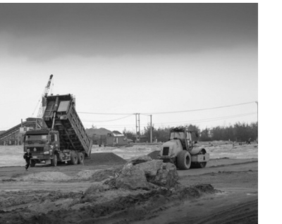
●Các đơn vị thi công đang đẩy nhanh tiến độ xây dựng các hạng mục. (Ảnh trong bài: T.Tuyến)
