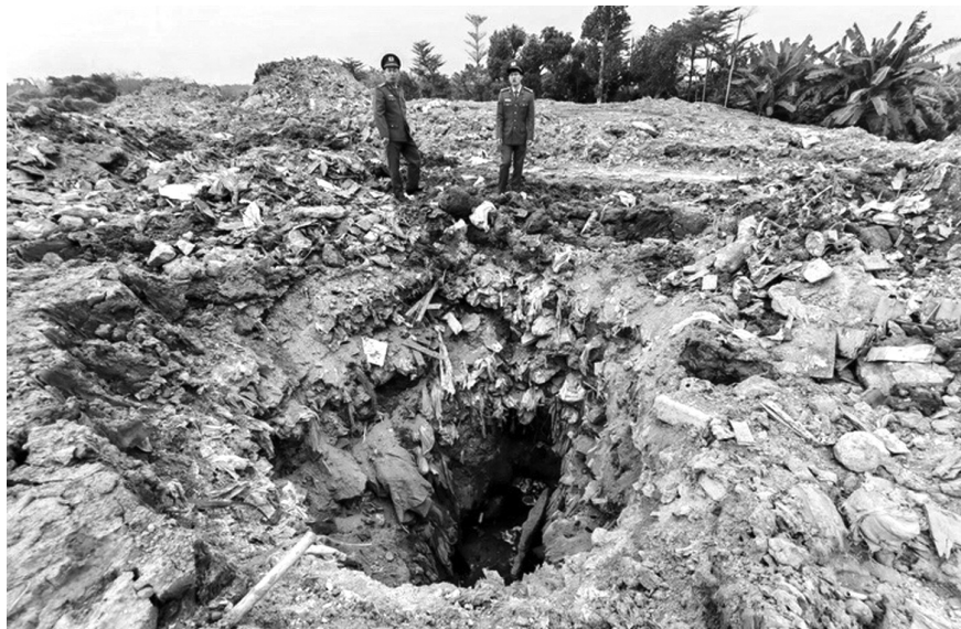
● Bãi chứa rác thải xây dựng trái phép ở xã Bát Tràng. (Ảnh: Công an Hà Nội)
