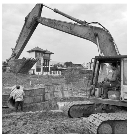
● BQLDA yêu cầu các nhà thầu đẩy nhanh việc thi công các hạng mục công trình.
