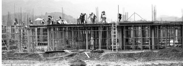
● Công trình điểm trường liên cấp A Lưới 3 đang triển khai thi công, bảo đảm tiến độ.
