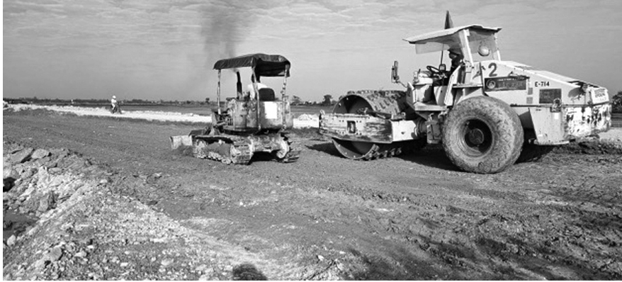
● Các nhà thầu đang đẩy nhanh tiến độ tại khu TĐC xã Phú Hồ. (Ảnh: Thùy Nhung)
