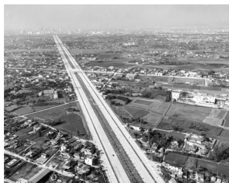
● Dự án sẽ triển khai theo hình thức đối tác công - tư (PPP), loại hợp đồng xây dựng - chuyển giao (BT).
