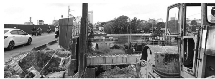
● Hạng mục nâng cấp, mở rộng cầu Võ Dạ hiện đang ngổn ngang. (Ảnh: T.Nhung)
