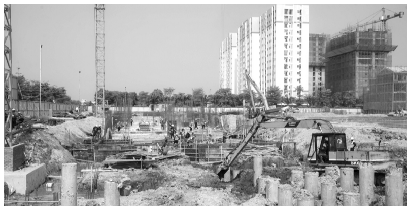
● Nhiều dự án NOXH đang triển khai xây dựng tại Huế.
