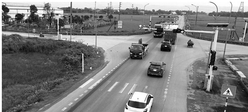
● QL1 tuyến tránh TP Hà Tĩnh (cũ) chỉ 2 làn xe, không có dải phân cách giữa, nhiều năm qua thường xuyên xảy ra các vụ TNGT. (Ảnh: hatinh.gov.vn)
