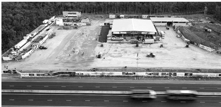
●Trạm dừng nghỉ tạm trên cao tốc Bình Thuận. (Ảnh: Phước Tuấn)
