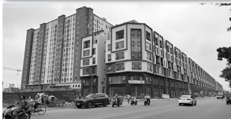
● Phát triển nhà ở xã hội chủ nghĩa tại Hải Phòng “công bằng, nhân văn, đoàn kết”. (Trong ảnh: Dự án nhà ở xã hội thành phố Hải Phòng tại số 183 Lê Thánh Tông)
