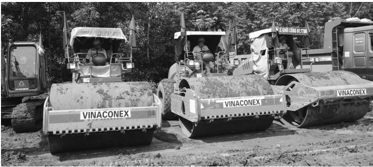
● Các máy móc thiết bị được tập kết để thi công đường ĐT.770B. (Ảnh: Tiến Dũng)
