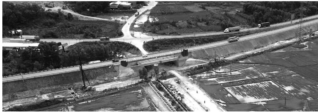
●Khu vực nút giao cao tốc Cam Lộ - La Sơn với đường tránh phía tây TP Huế đang được triển khai thi công. (Ảnh: Thùy Nhung)
