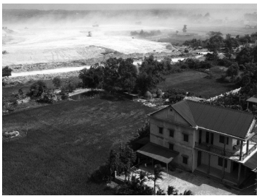
● Nhìn từ trên cao có thể thấy bụi từ công trường bốc lên.
