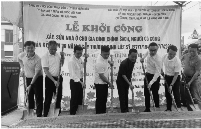
● Các đại biểu thực hiện nghi lễ khởi công. (Ảnh trong bài: PV)
