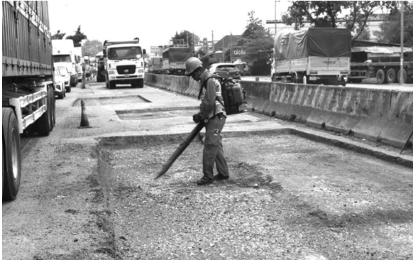
●CĐT cam kết sẽ hoàn thành toàn bộ dự án vào cuối tháng 8/2026. (Ảnh: Cục Đường bộ)
