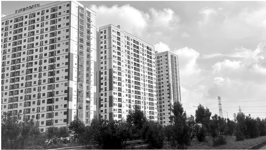
● Bắc Ninh phấn đấu hoàn thành tối thiểu khoảng 135.002 căn nhà ở xã hội vào năm 2030. (Trong ảnh: Dự án nhà ở xã hội Evergreen, phường Nếnh - Ảnh minh họa)
