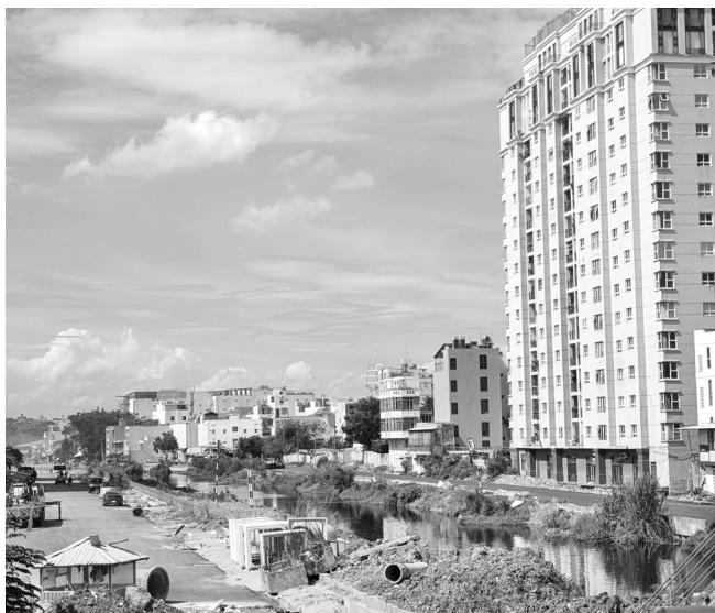
● Một dự án nạo vét, cải tạo kênh, rạch tại TP HCM.
