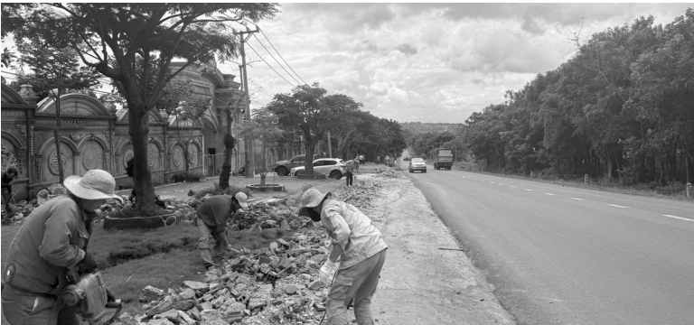
● Chủ đầu tư đã nộp phạt, tự nguyện tháo dỡ công trình vi phạm. (Ảnh: Đinh Huy)
