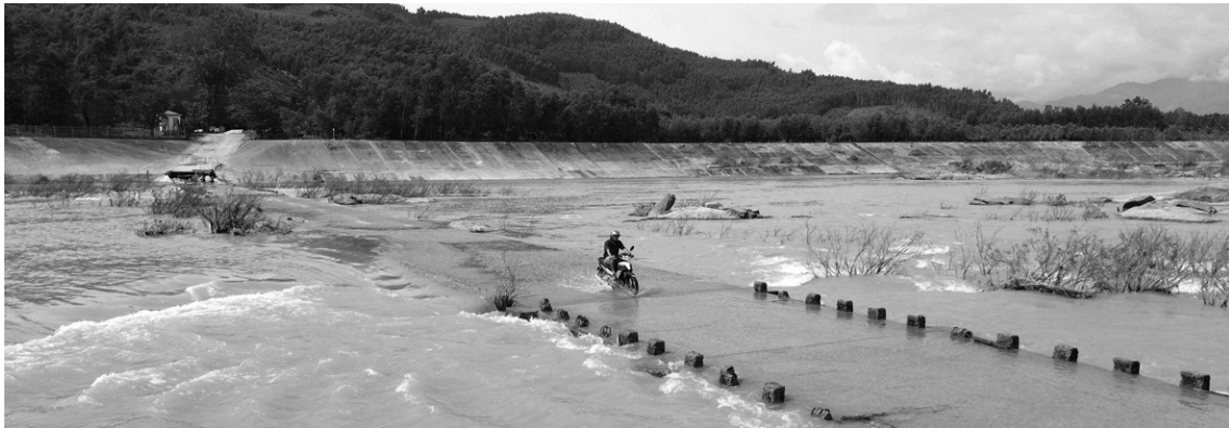
● Cầu tràn Thạch Nham hiện hữu, khu vực được xem xét trong phương án điều chỉnh hướng tuyến dự án cầu và đường ĐT.623B.
