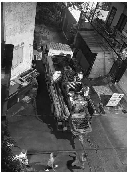
● Nhận được thông tin về công trình thi công đổ bê tông đêm, phường An Nhơn đã kiểm tra, xử lý ngay. (Ảnh trong bài: B.Yên)
