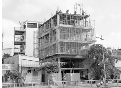
●Một công trình xây dựng đang được thực hiện tại TP HCM. (Ảnh: Trường Giang)
