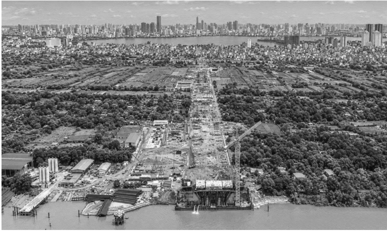
● Dự án cầu Tứ Liên và đường dẫn hai đầu cầu đang được triển khai góp phần mở rộng không gian phát triển. (Ảnh: Hanoi.gov.vn)
